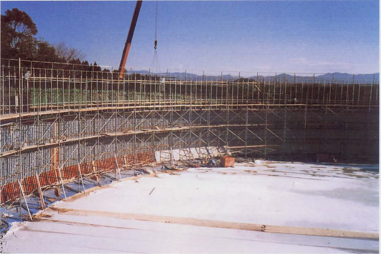
■ファームポンドタンク
